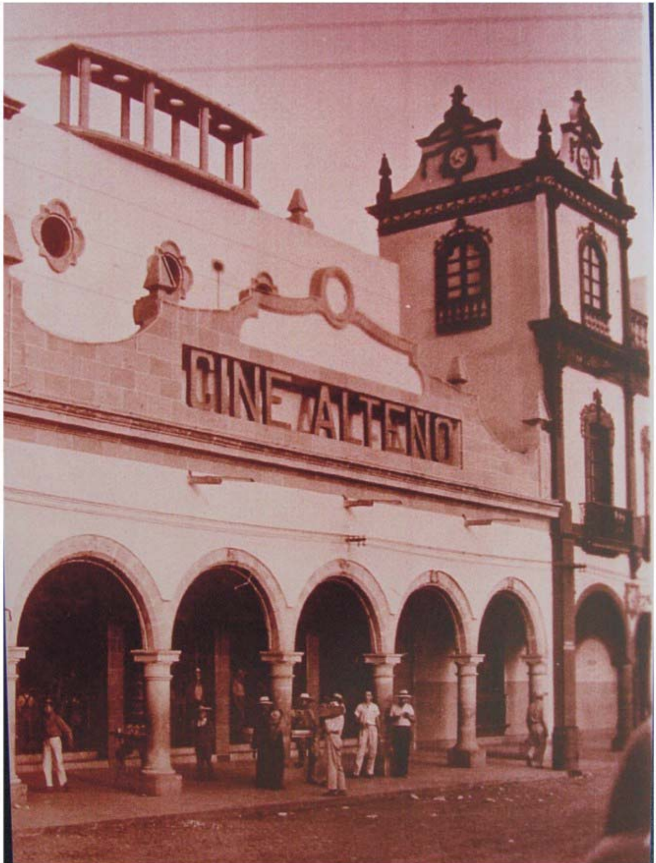
FACHADA DEL CINE ALTEÑO
